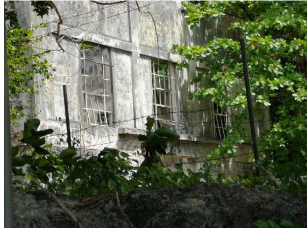
Limestone factory (Four à Chaux) at Ville Noire, Rivière La Chaux
